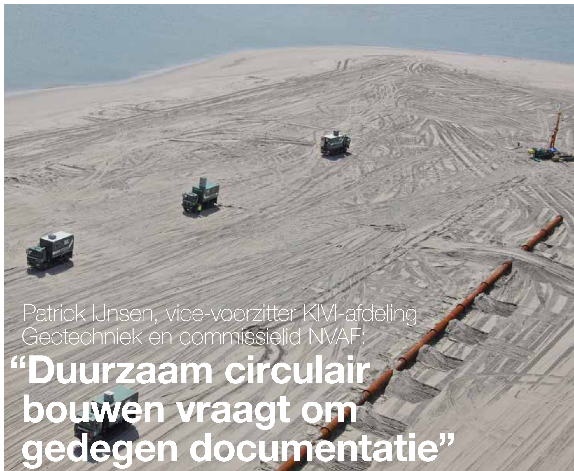
Mos Grondmechanica BV, 2e Maasvlakte
