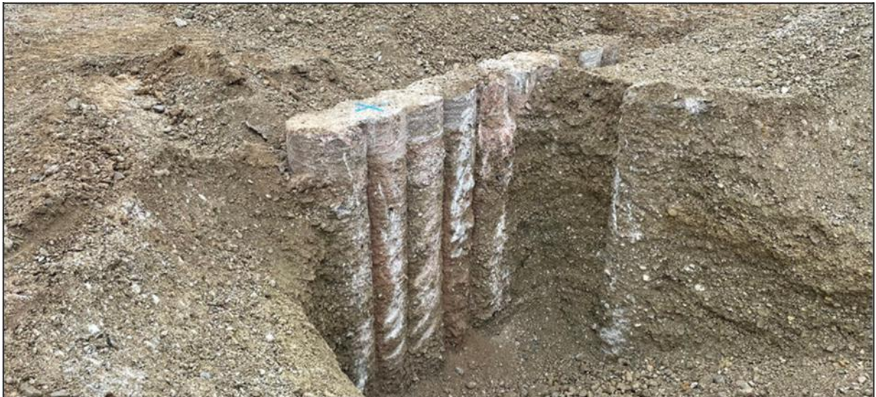
Fig. 14: Secant pile wall
